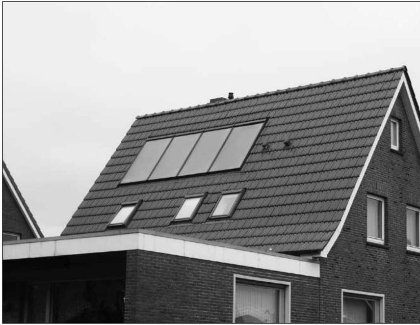
Wenn es nach dem Vorschlag der Verwaltung geht, sollen Solaranlagen nur noch auf der Rückseite von Häusern zu sehen sein, wie hier in der Südhoffstraße.
