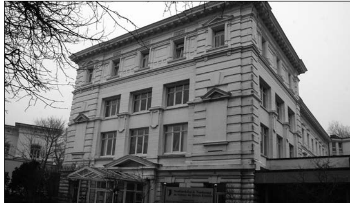
Die Appartements sollen an die Nordseeklinik angebunden sein.
